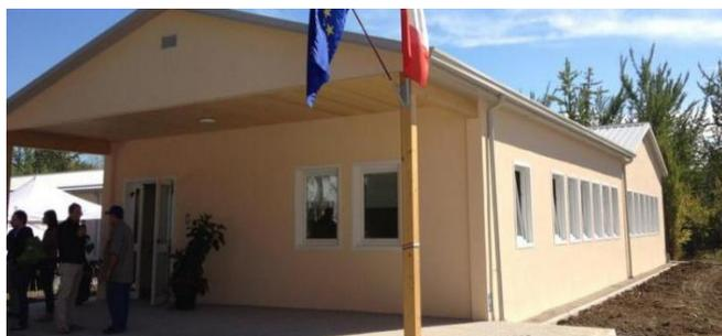
delle scuole che comportavano tempi lunghi di riparazione. Sono stati scelti sistemi costruttivi prelaborati idonei a garantire tempi di realizzazione compatibili con l'apertura dell'anno scolastico 2012-2013 e un utilizzo prolungato nel tempo, in attesa del ripristino o della ricostruzione degli edifici danneggiati.
