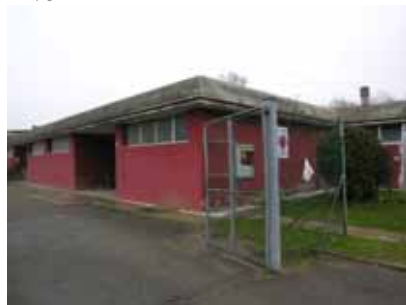
Prossima realizzazione di centro giovani mediante ristrutturazione con sopraelevazione dello spogliatoi calcio in disuso
