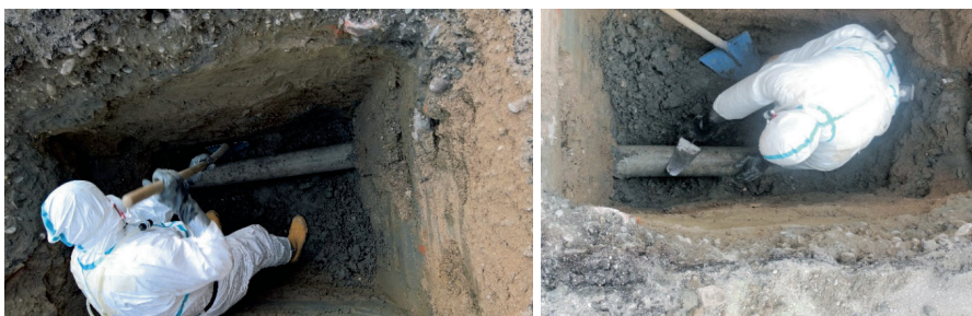
Figura 14 - Messa a giorno delle tubazioni in cemento amianto mediante attrezzi manuali.
