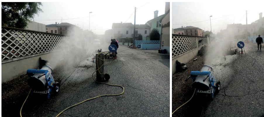
Figura 5 - Cannone nebulizzatore nell'area d'intervento.
