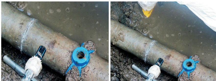
Figura 16 - Particolare del punto di derivazione.
