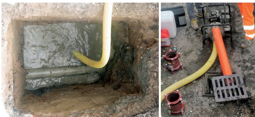
Figura 4 - Convogliamento dell'acqua a fondo scavo e scarico in fognatura.
