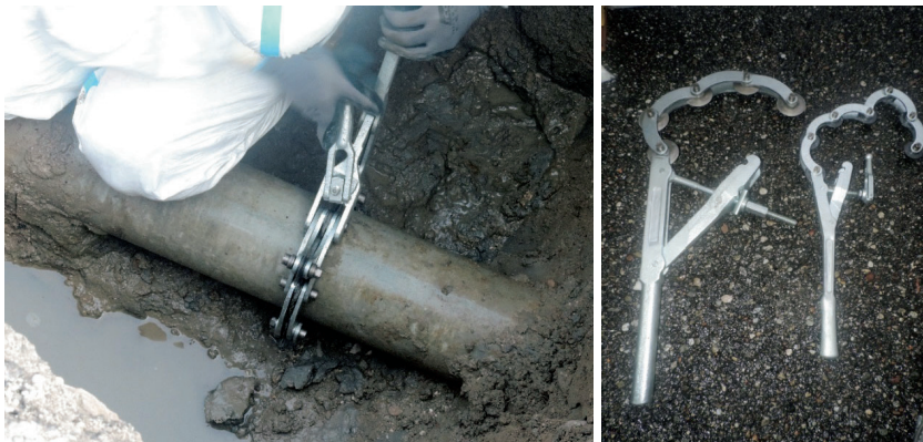
Figura 8 - Taglio di una tubazione mediante tagliatubi manuale a catena.
