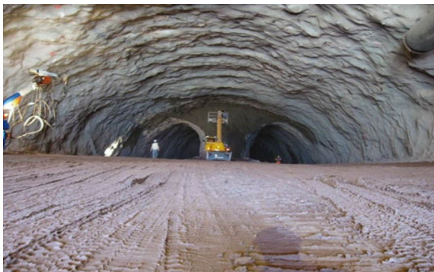
FIG. 2 AMIANTO NATURALE, OFIOLITI Scavo di gallerie in roccia.
