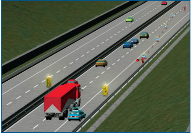
Figura 5 Misura organizzativa: adeguato allestimento di cantiere stradale su strada extraurbana con due corsie per senso di marcia
