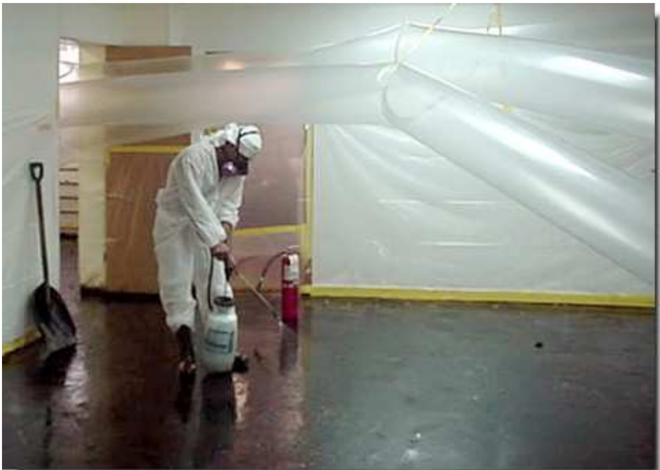
Figura 20 - Confinamento statico e dinamico
