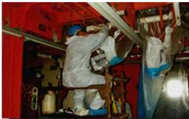
Figura 53 - Posizionamento del Glove-Bag
