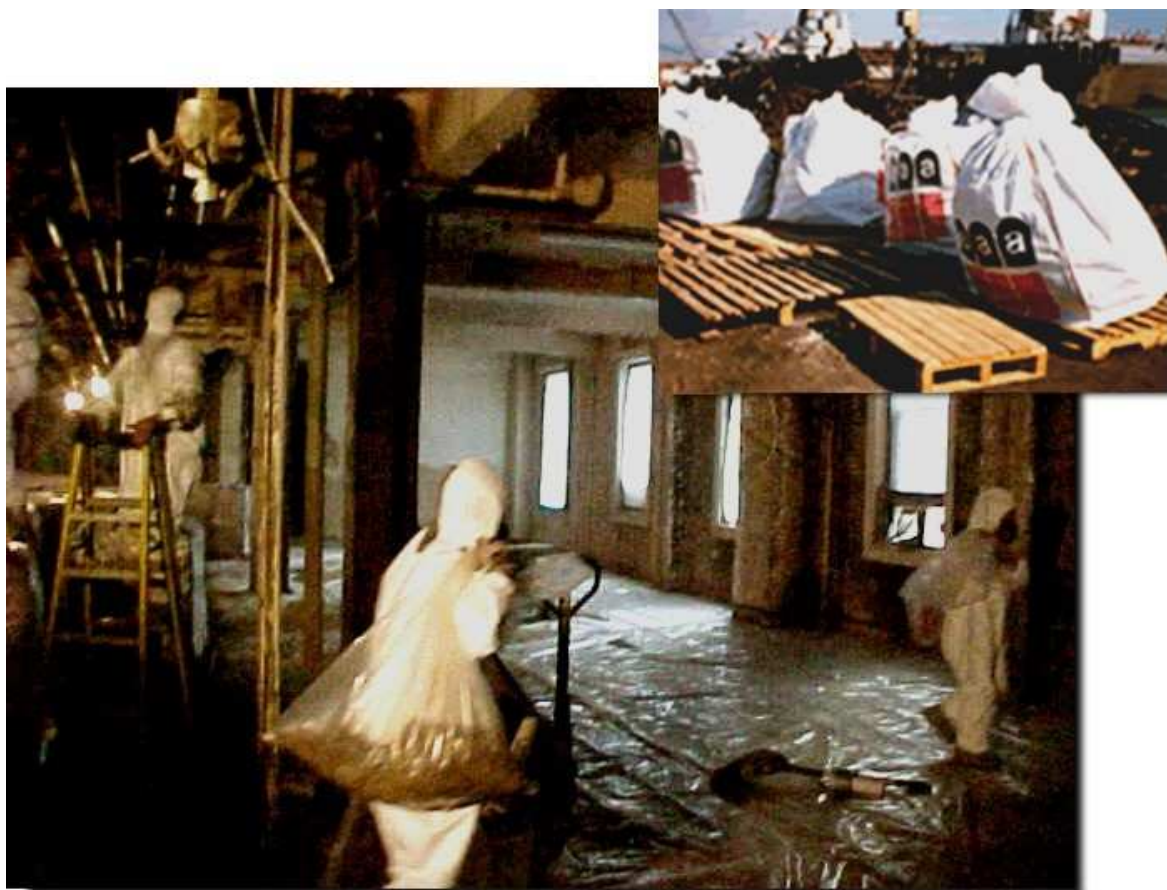
Figura 27 - Confezionamento ed etichettatura per lo smaltimento
