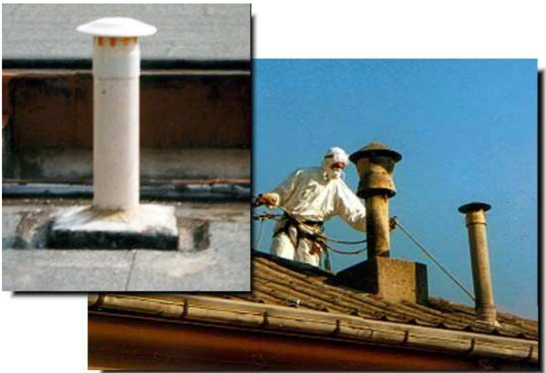
Figura 42 - Manutenzione di canna fumaria
