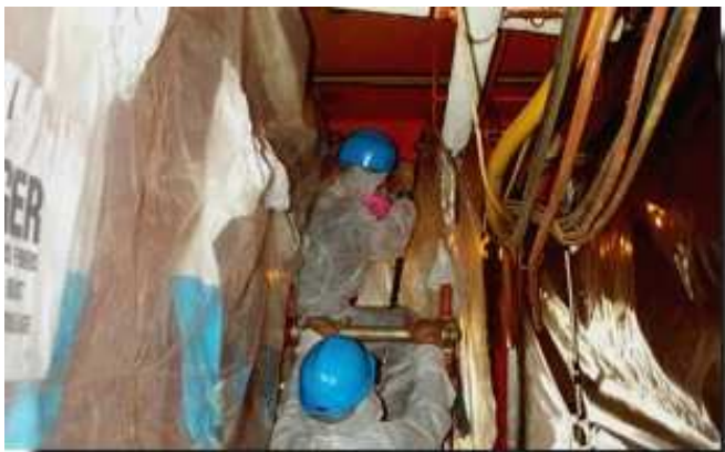
Figura 50 - Installazione opere provvisorie
