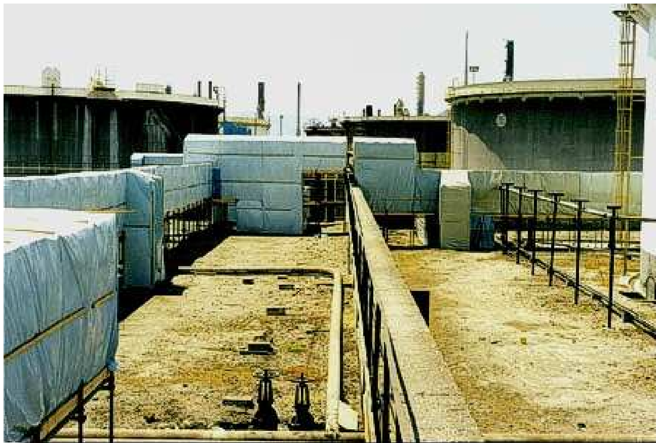
Figura 63 - Predisposizione area di cantiere
