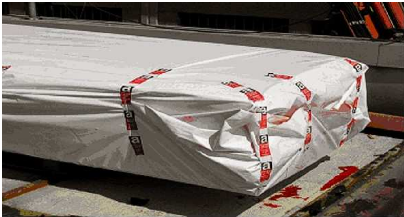
Figura 31 - Confezionamento ed etichettatura per lo smaltimento
