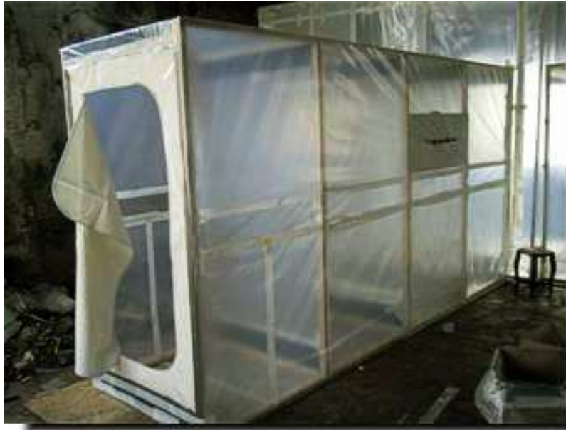
Figura 24 - Decontaminazione dei rifiuti e/o attrezzature
