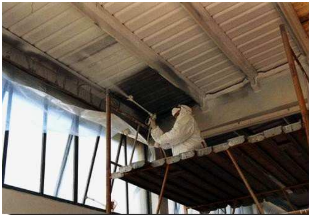
Figura 62 - incapsulamento
