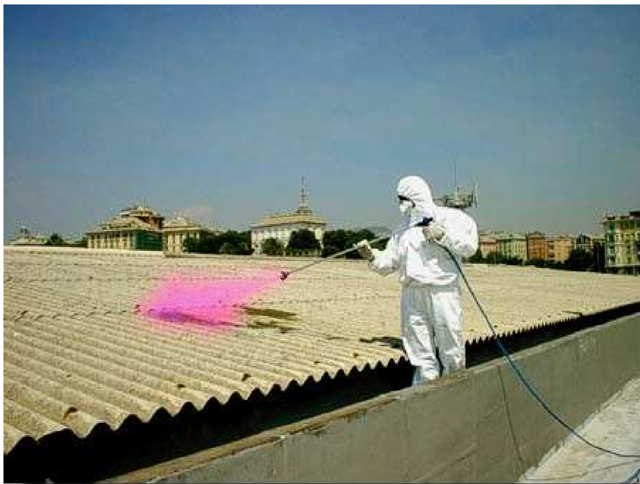
Figura 60 - Bagnatura del cemento-amianto
