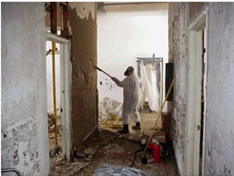
Figura 26 - Rimozione rivestimento dopo il trattamento
