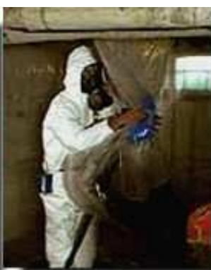
Figura 55 - Torsione del sacco
