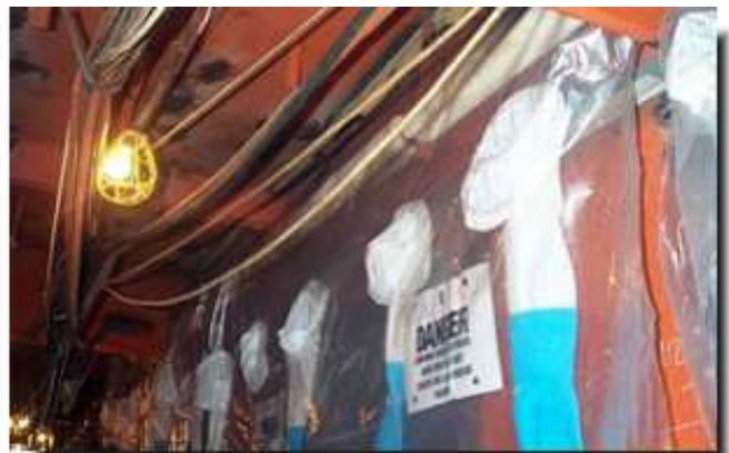
Figura 51 - Isolamento della zona con Glove-Bag
