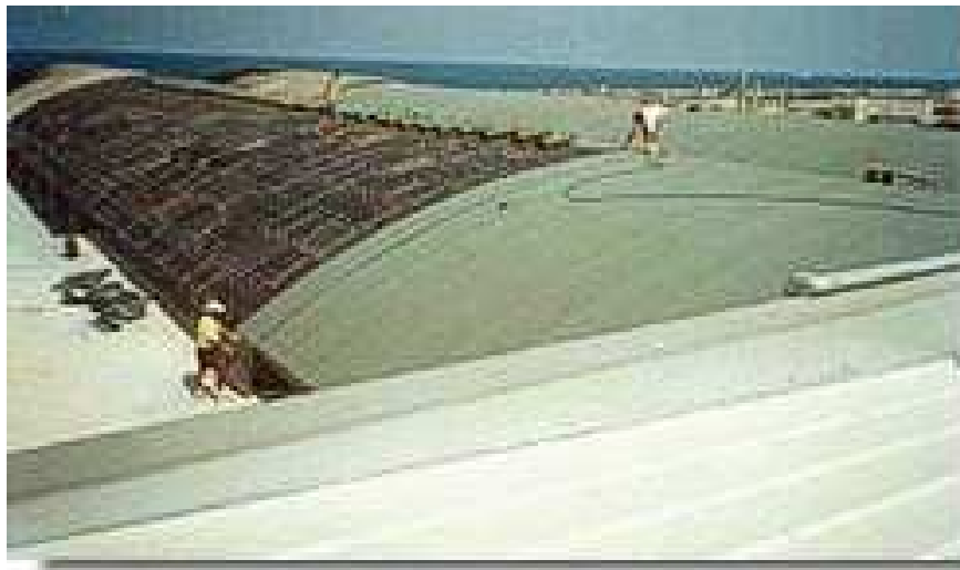
Figura 17 - Rivestimento di una copertura
