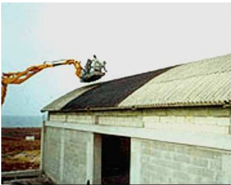
Figura 61 - Posa della sovracopertura
