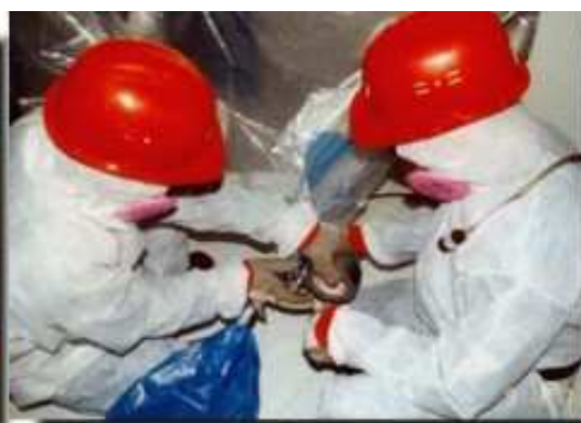
Figura 56 - Sigillatura del sacco con nastro
