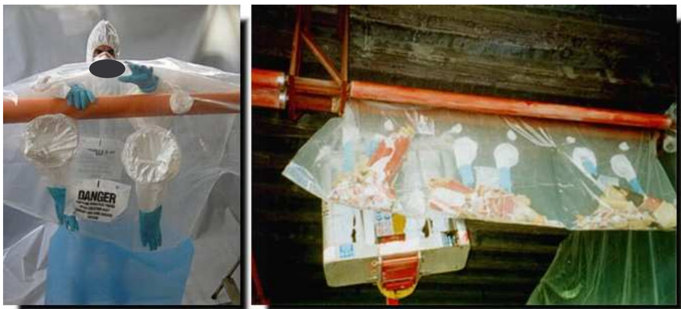
Figura 49 - Tecnica del Glove-Bag
