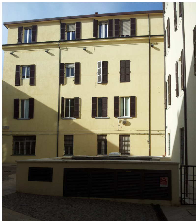
Figura 5. La centrale termica a servizio dell'intero complesso di edifici comunali rinnovata nel 2001.
