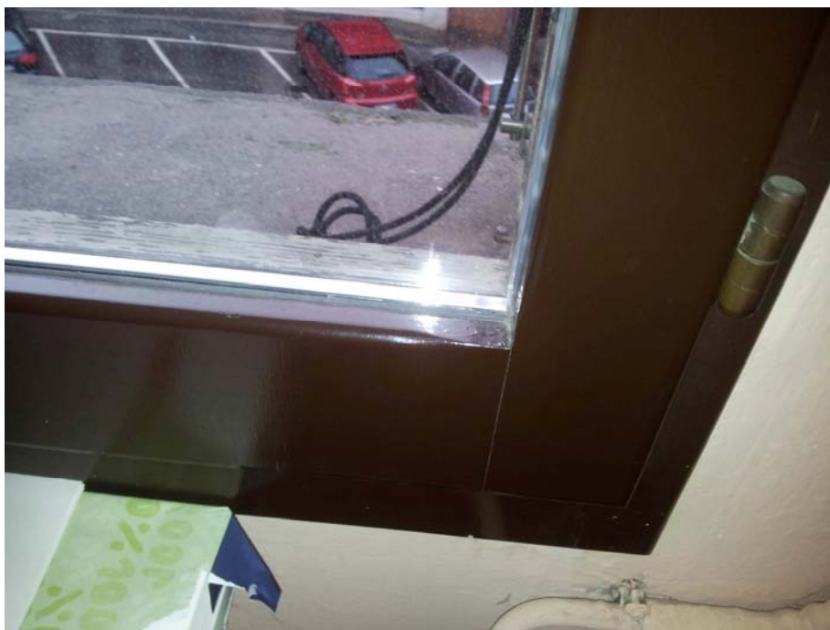
Figura 4. Infissi in legno con vetrocamera 4/8/4 in buono stato di conservazione.
