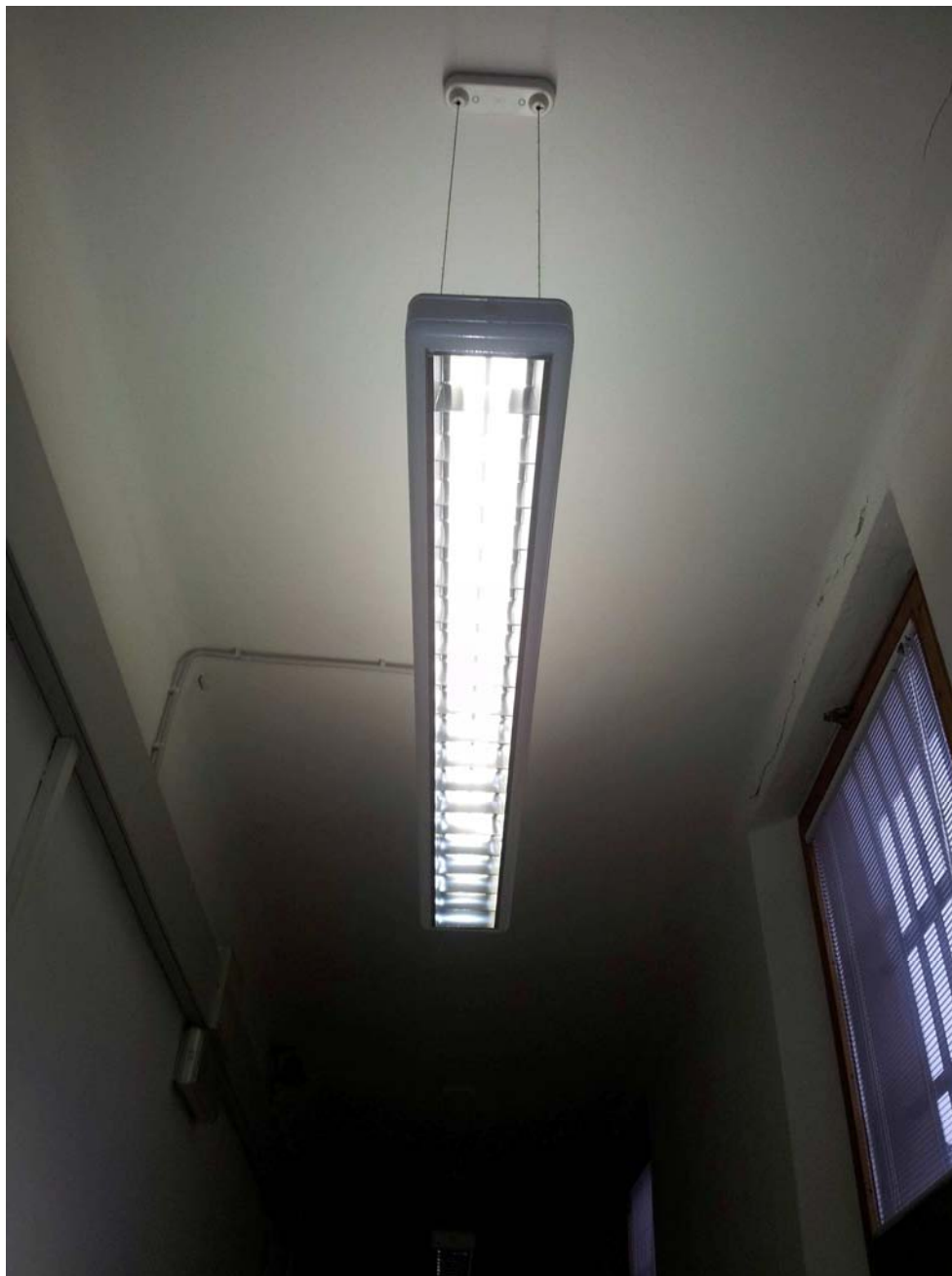
Figura 6. Plafoniere al neon presenti in tutti gli uffici ed i corridoi dell'edificio.
