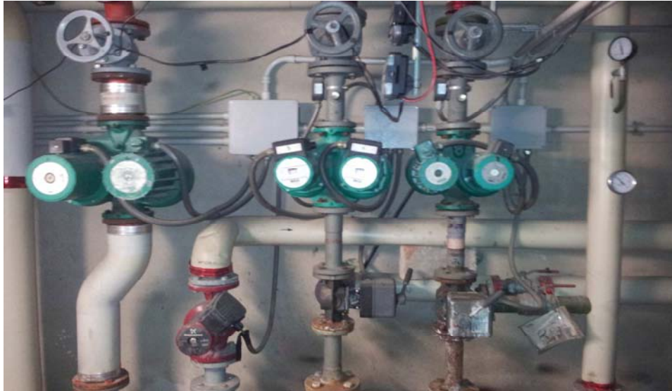
Figura 8. Il grippo di pompe presenti all'interno della centrale termica
