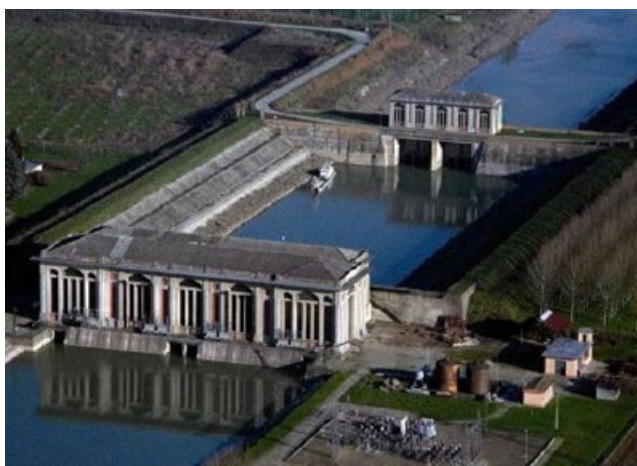
Figura 4 - Idrovora delle Pilastresi. Stellata di Bondeno (FE).
