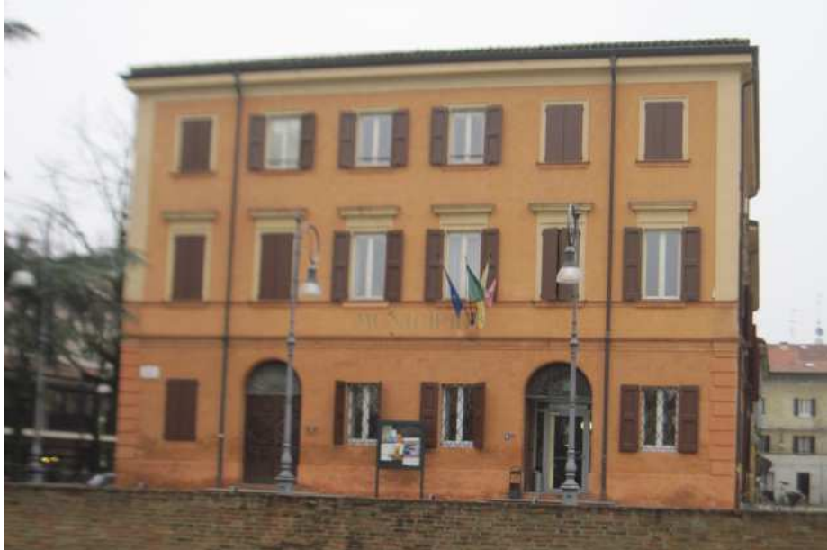
Figura 3. Il blocco A a tre piani in muratura portante della sede comunale di Piazza della Repubblica n.1
