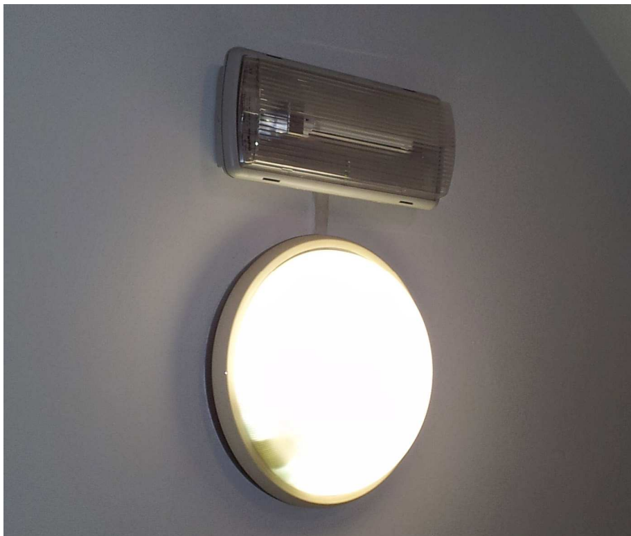
Figura 4. Prese elettriche presenti nel blocco A. Plafoniere al neon presenti in tutti e tre i blocchi.
