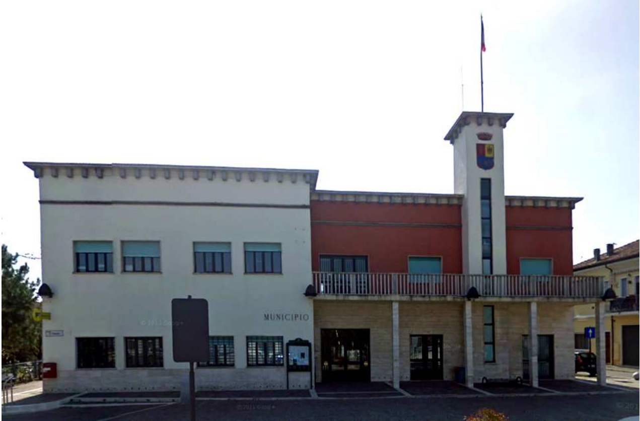
Figura 3. Ingresso alla sede comunale. Si possono distinguere facilmente i due blocchi che costituiscono l'intero complesso edilizio
