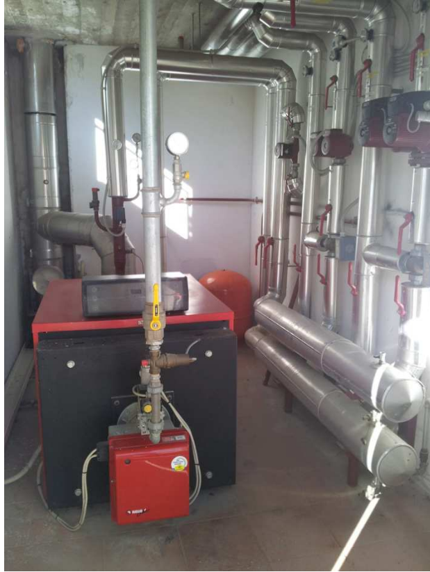
Figure 11 e 12. Sistema di generazione e sistema di emissione in ventilconvettori. Si nota anche il sistema di distribuzione del vettore termico caratterizzato da tubazioni perfettamente isolate.
