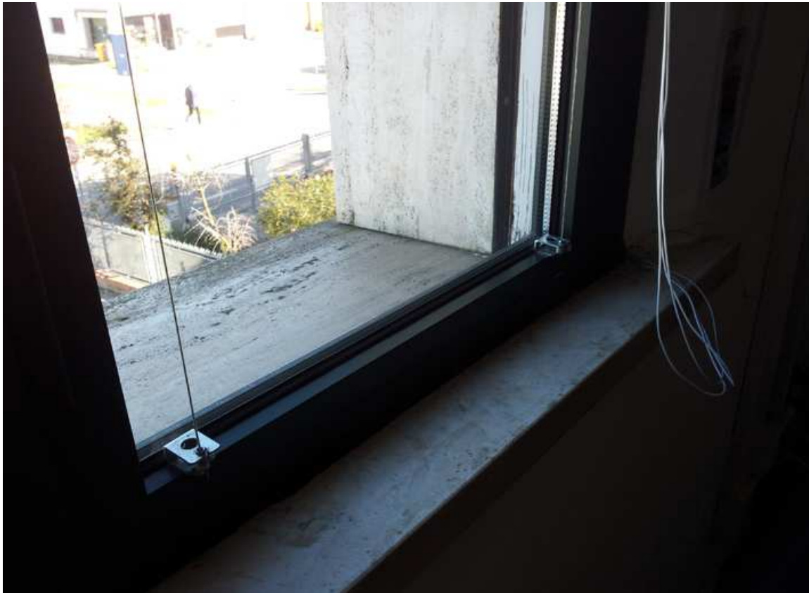
Figura 5. Infissi in PVC con vetrocamera 4/8/4 installati sul fronte dell'edificio che si affaccia su Piazza Toschi
