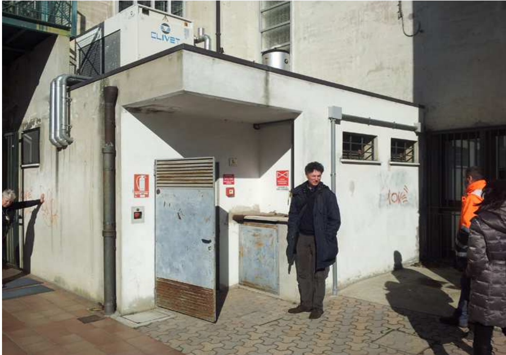
Figura 9. Accesso alla centrale termica. In copertura è visibile l'unità esterna dell'impianto di climatizzazione
